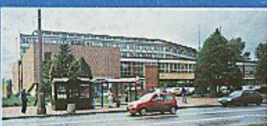
10. gmach Wydziału Metalurgii i Inżynierii Materiałowej
