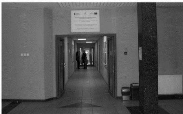
Wyremontowane pomieszczenia w budynku głównym Wydziału Zarządzania w ramach projektu „Modernizacja infrastruktury dydaktycznej Politechniki Częstochowskiej – etap I”
