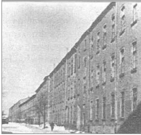
Gmach Szkoły Inżynierskiej w Częstochowie po remoncie - 1950 r.
