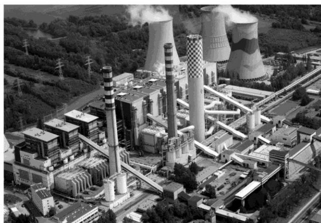
Bloki energetyczne w PGE Elektrownia Turów S.A.
