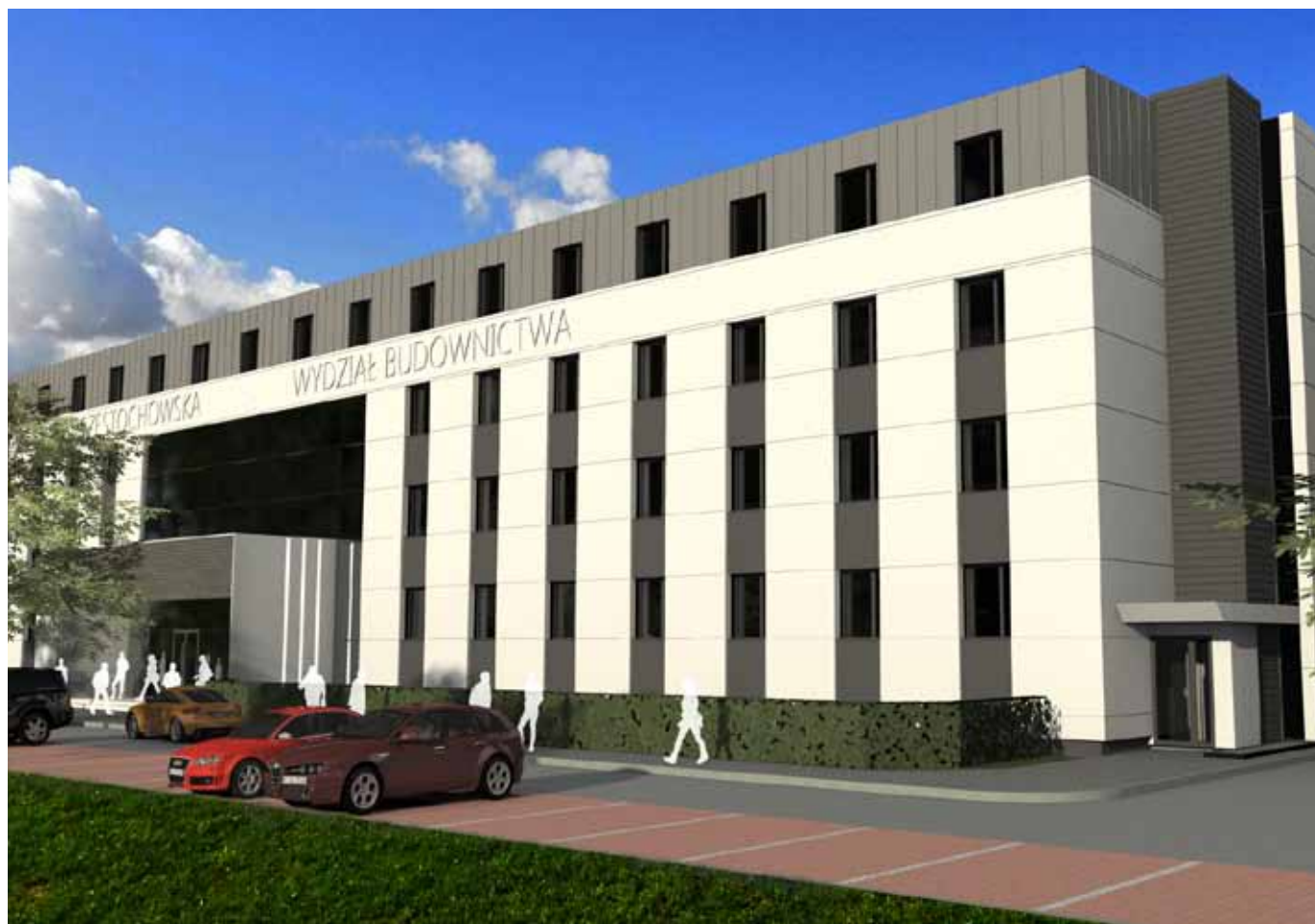
Tak już niedługo będzie wyglądała nowa elewacja Wydziału Budownictwa
