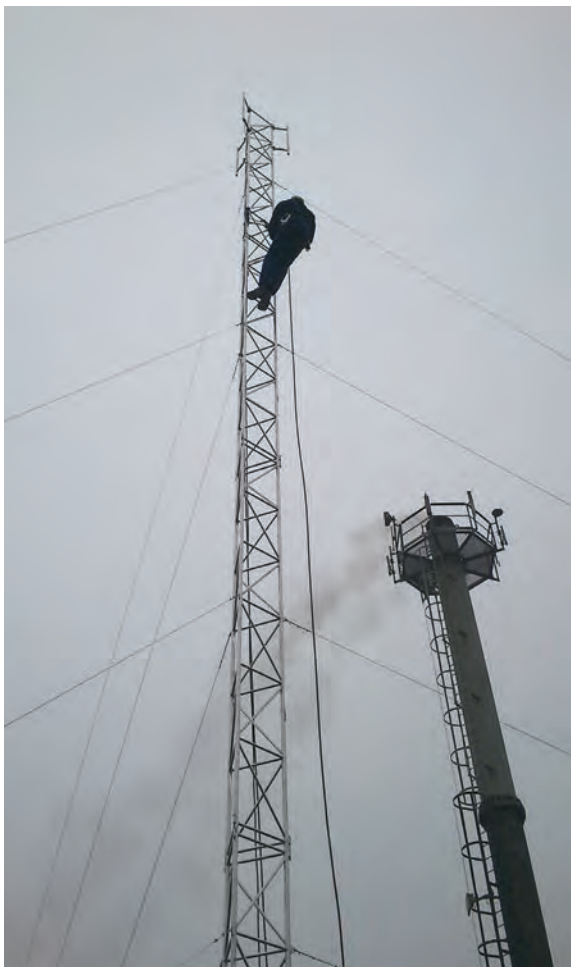
Instalacja jednego z ponad trzydziestu masztów dla urządzeń bezprzewodowych
