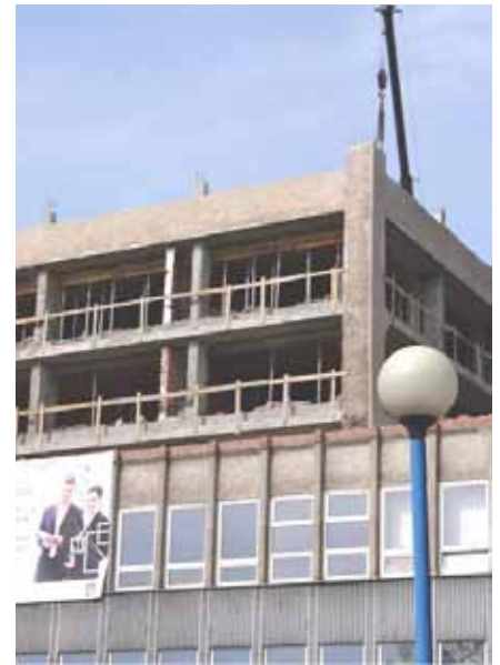
Budynek Wydziału Elektrycznego podczas inwestycji
