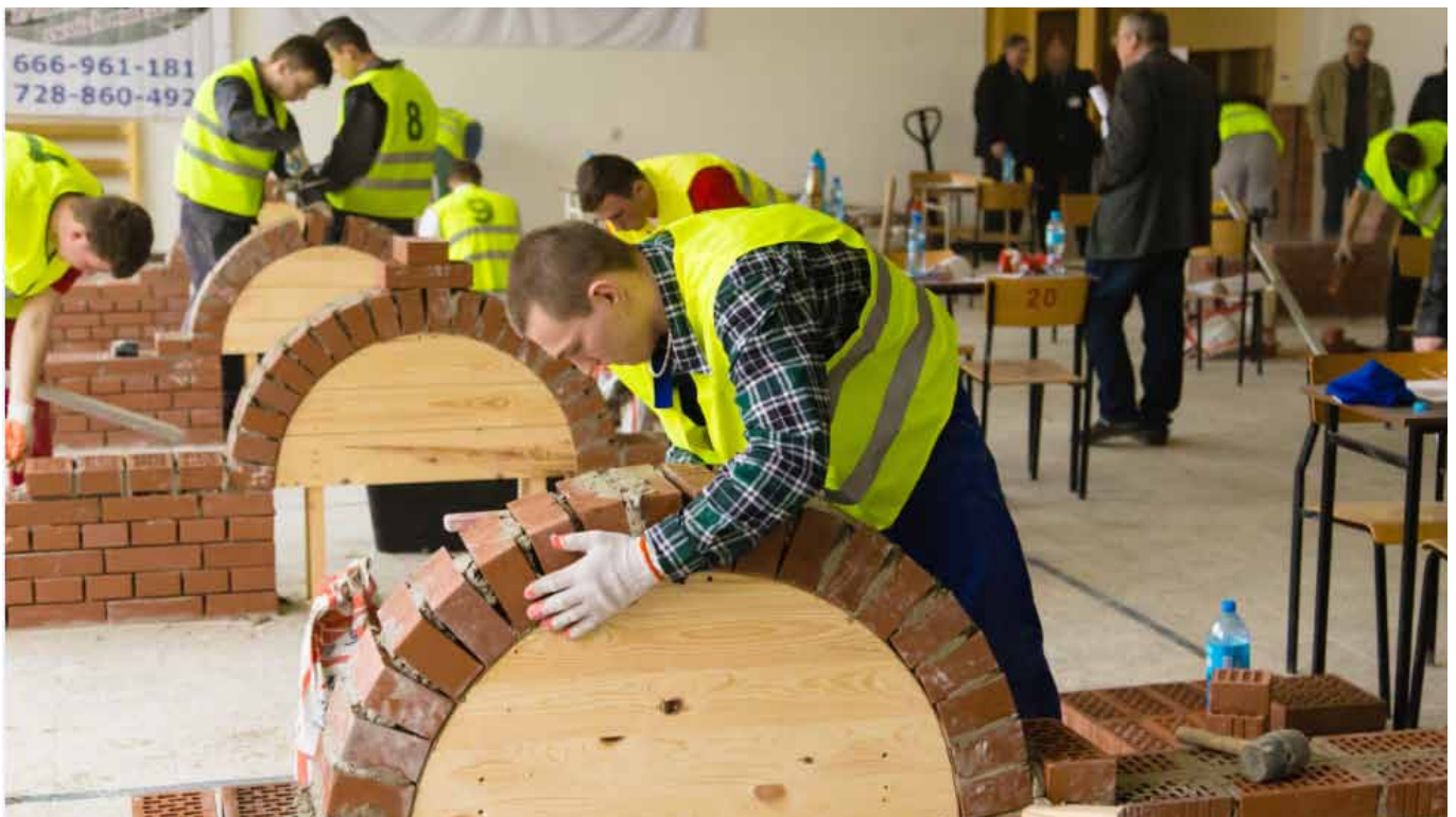
Część praktyczna konkursu odbyła się w hali budowlanej Centrum Kształcenia Zawodowego i Ustawicznego
